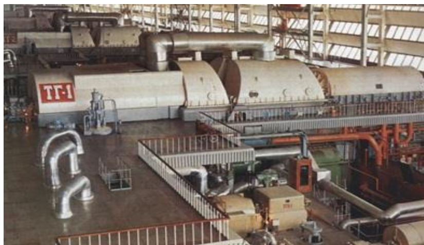
4 сурет - «Харьков турбина зауытының» №1-4 стационарлық нөмірлі К500-240 сериялы турбиналары
